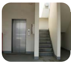
五階エレベーターと六階？への階段
