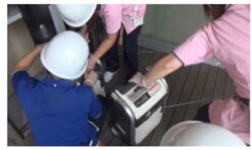
発電機使用の様子
